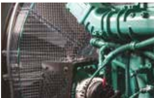
Rotierende und heiße Bauteile berührungssicher geschützt
