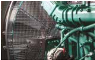
Rotierende und heiße Bauteile berührungssicher geschützt
